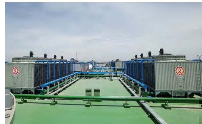
Thiết kế, cung cấp và lắp đặt hệ thống tháp giải nhiệt nước
