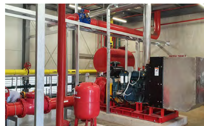
Thiết kế, cung cấp và lắp đặt hệ thống PCCC
