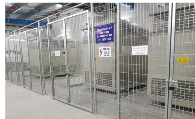
Thiết kế, cung cấp và lắp đặt hệ thống máy biến áp
