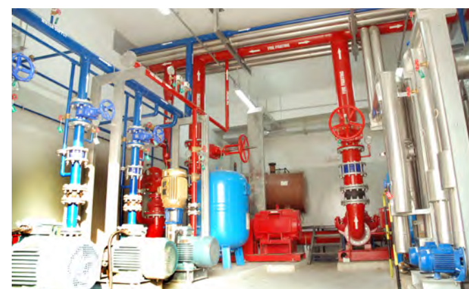
Thiết kế, cung cấp và lắp đặt hệ thống cấp nước sinh hoạt
