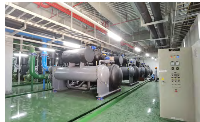
Thiết kế, cung cấp và lắp đặt hệ thống thông gió và điều hòa không khí, Chiller và AHU
