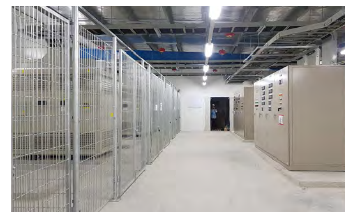
Thiết kế, cung cấp và lắp đặt hệ thống tủ điện hạ thế
