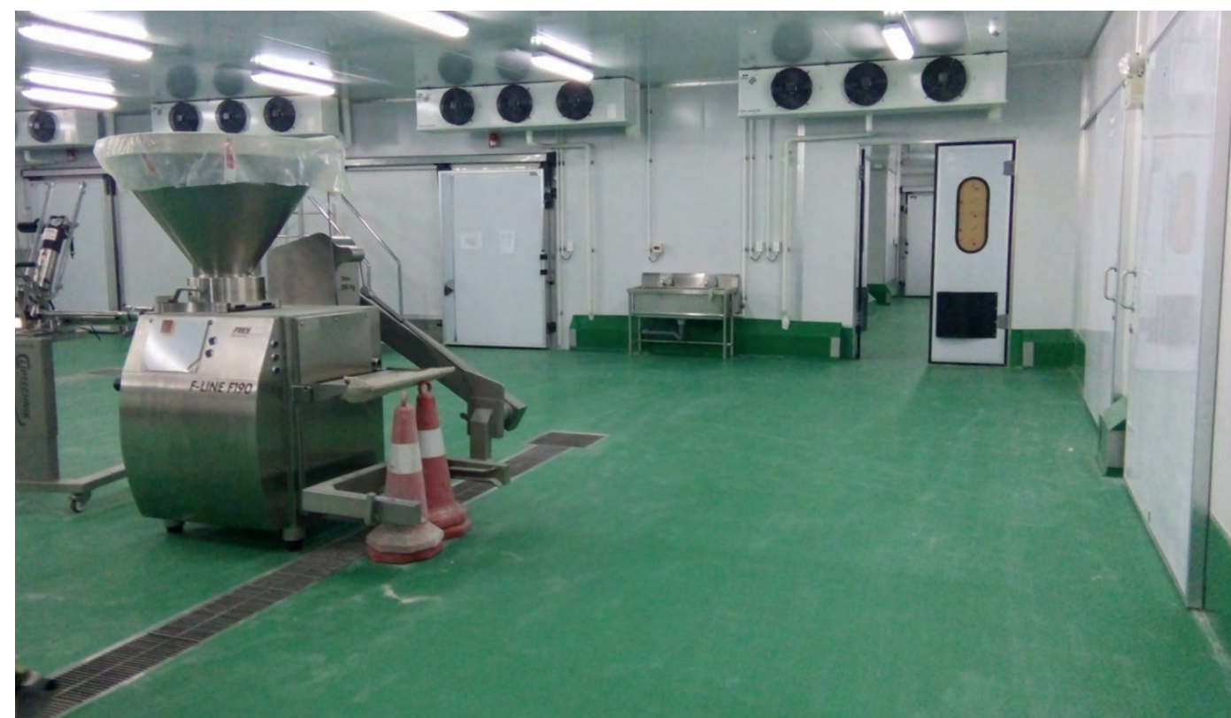
Thiết kế, cung cấp và lắp đặt hệ thống kho lạnh
